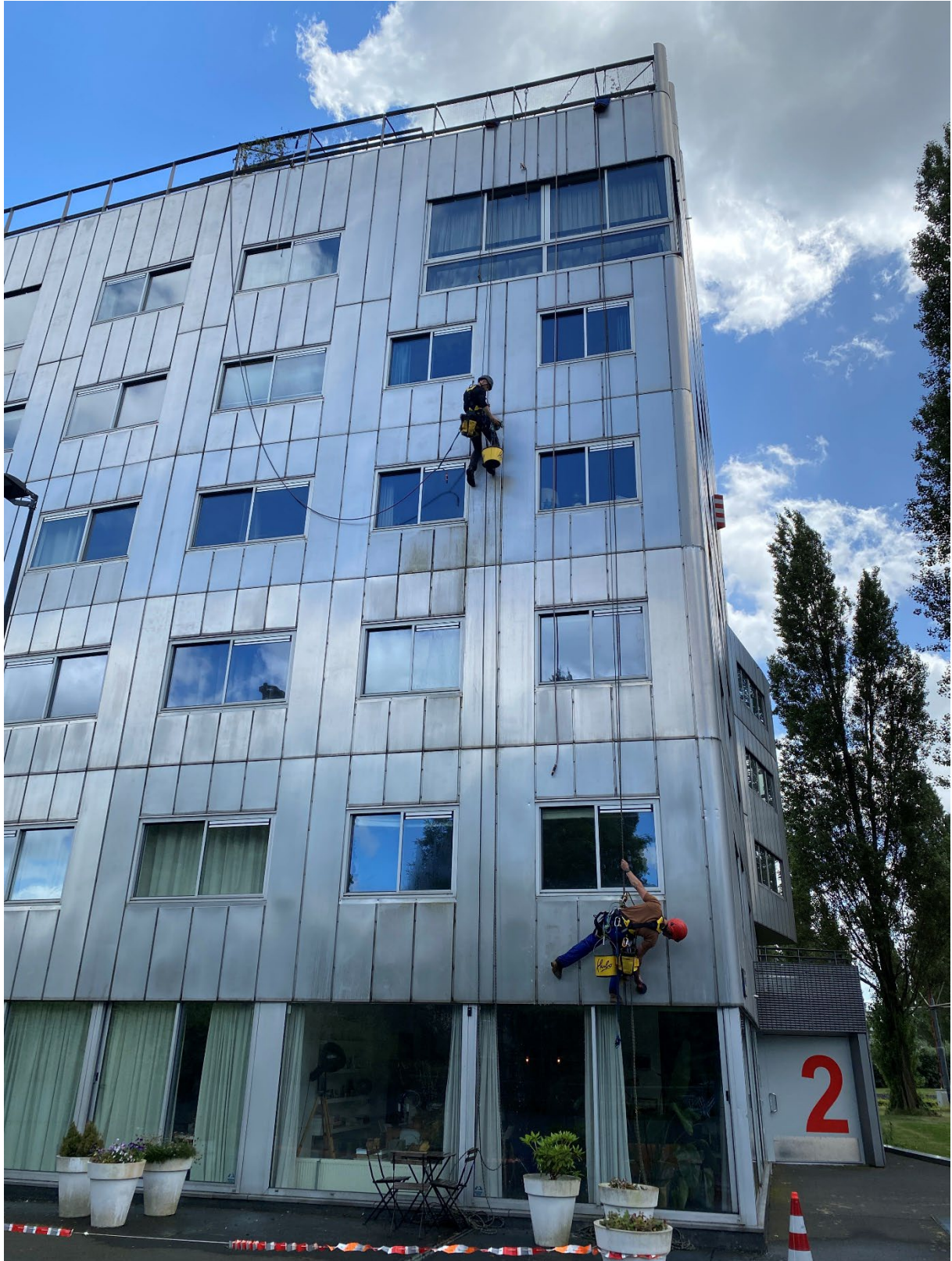
De laatste baan wordt onderhanden genomen door Constantijn en Koen van Building-Up
