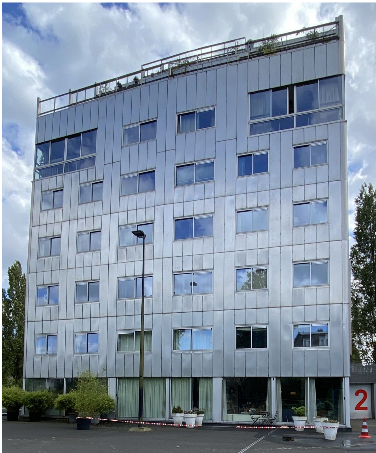
Het weer blinkende eindresultaat van de schoongemaakte noordgevel van Parktoren 2 Rietlandpark, Amsterdam
