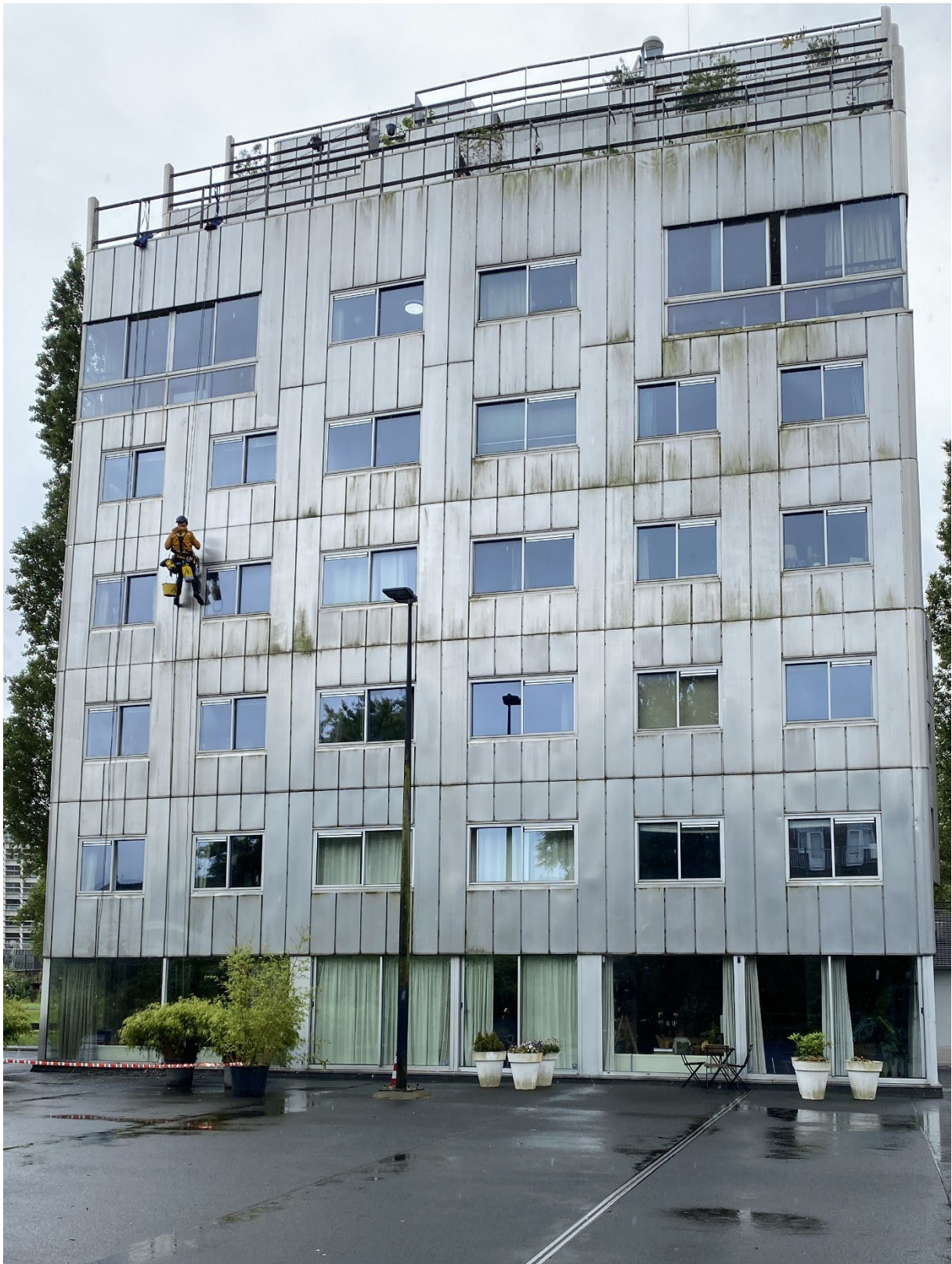
De eerste baan van de noordgevel wordt schoongemaakt
